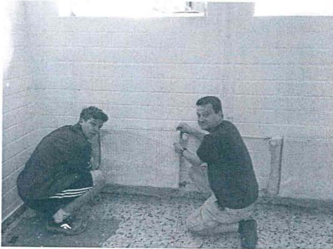
Vorbereitungen für die Malerarbeiten
